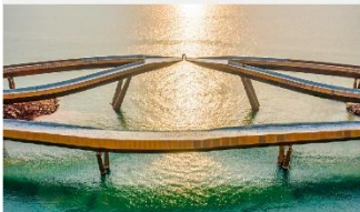
สะพานจูป
